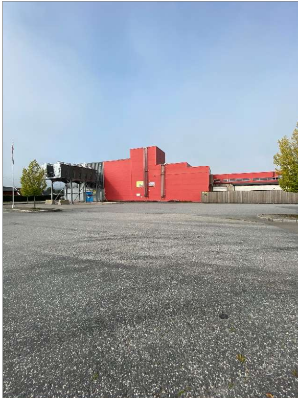
Bebyggelse sett fra Tyrihjellevien (Foto: SH Prosjekt)
