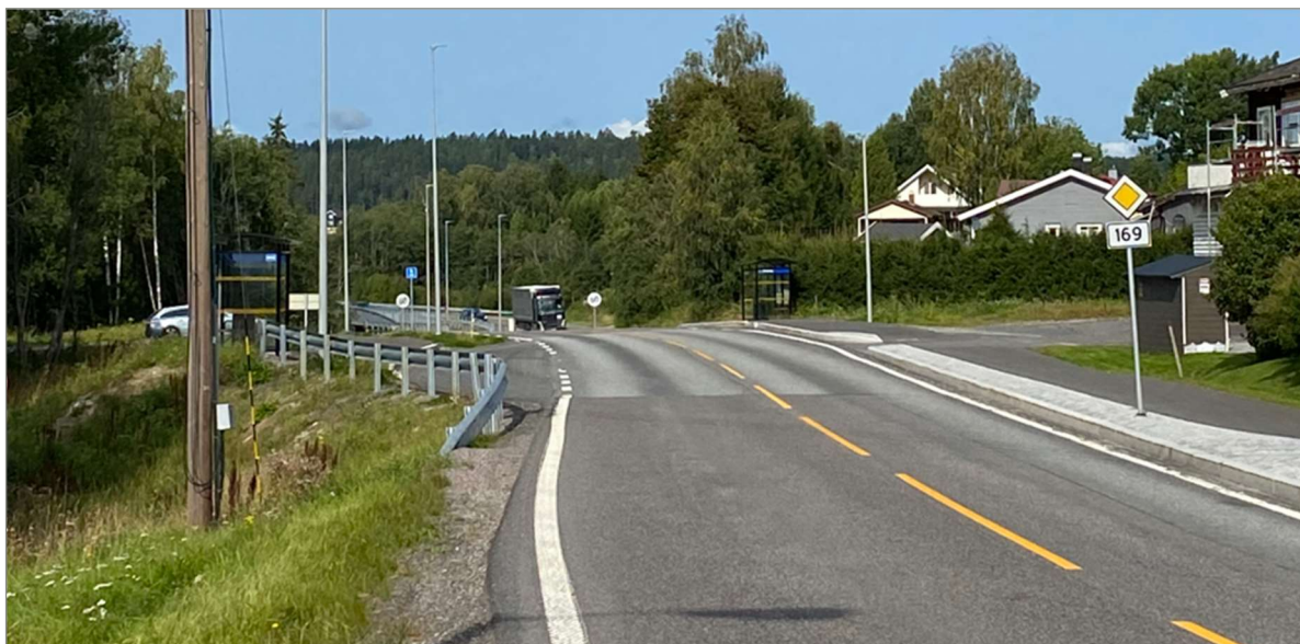
Bussholdeplasser Elverhøy, sør- og nordgående retning
