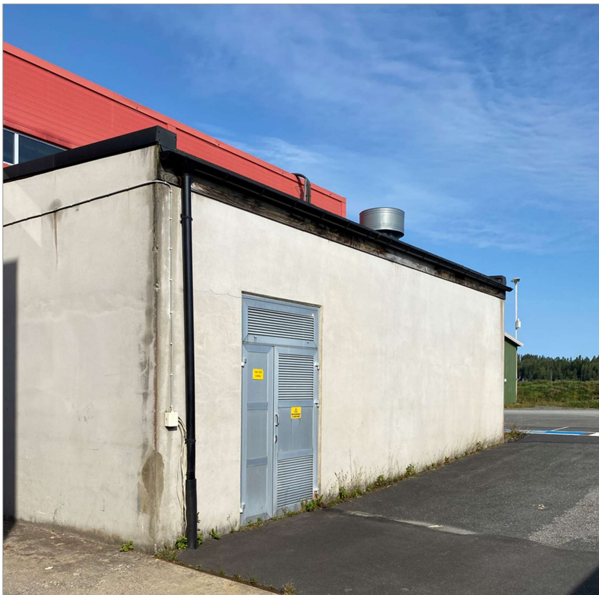
Nettselskapets trafo i planområdet (Foto: SH Prosjekt)
