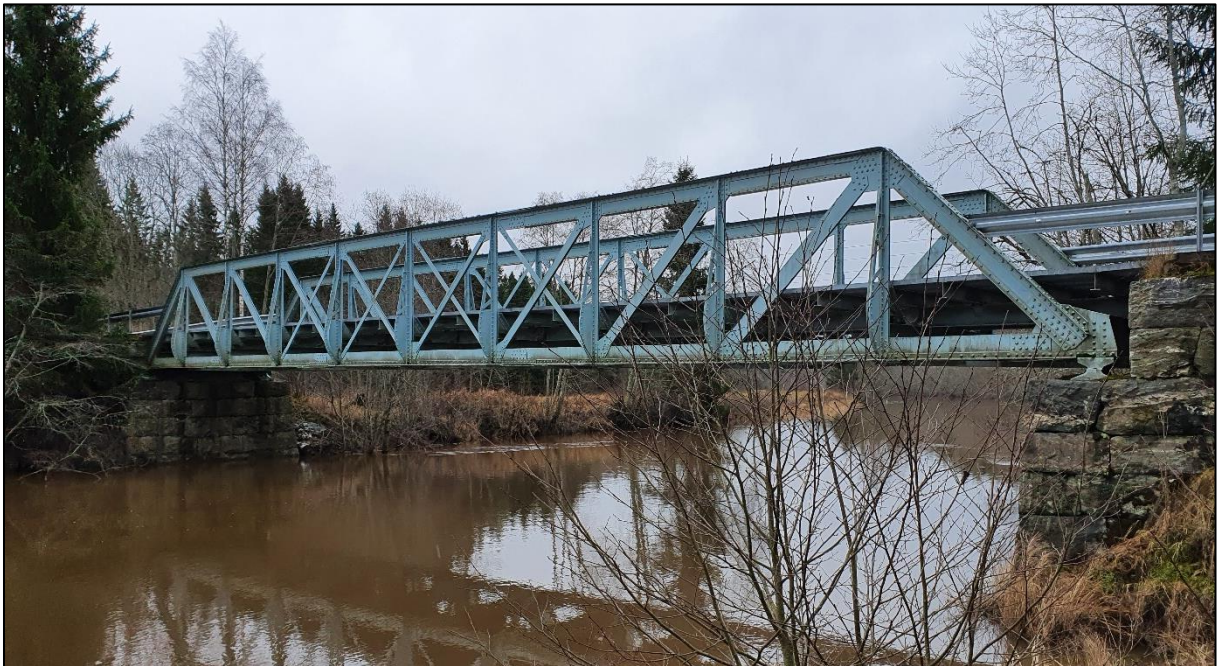
Figur 8: Bru 12 km nedstrøms planområdet.
