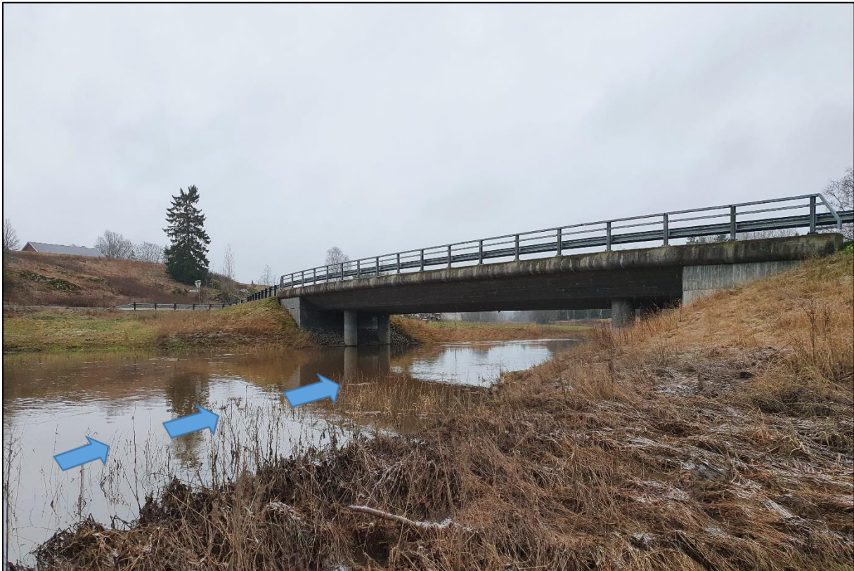
Figur 5: Bru Fv. 1460 over Hølandselva 500 m øst for planområdet.
