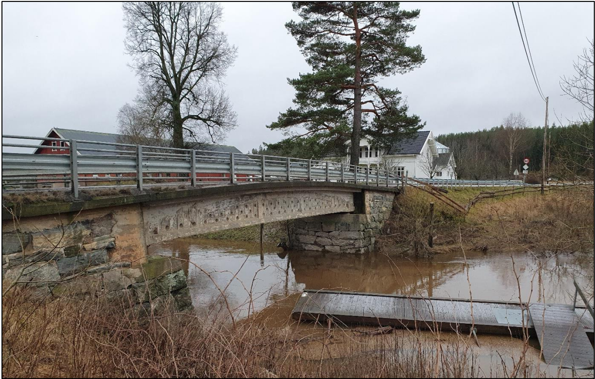
Figur 7: Bru 8,3 km nedstrøms planområdet.
