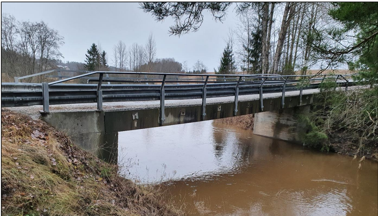
Figur 6: Bru 2,8 km nedstrøms planområdet.
