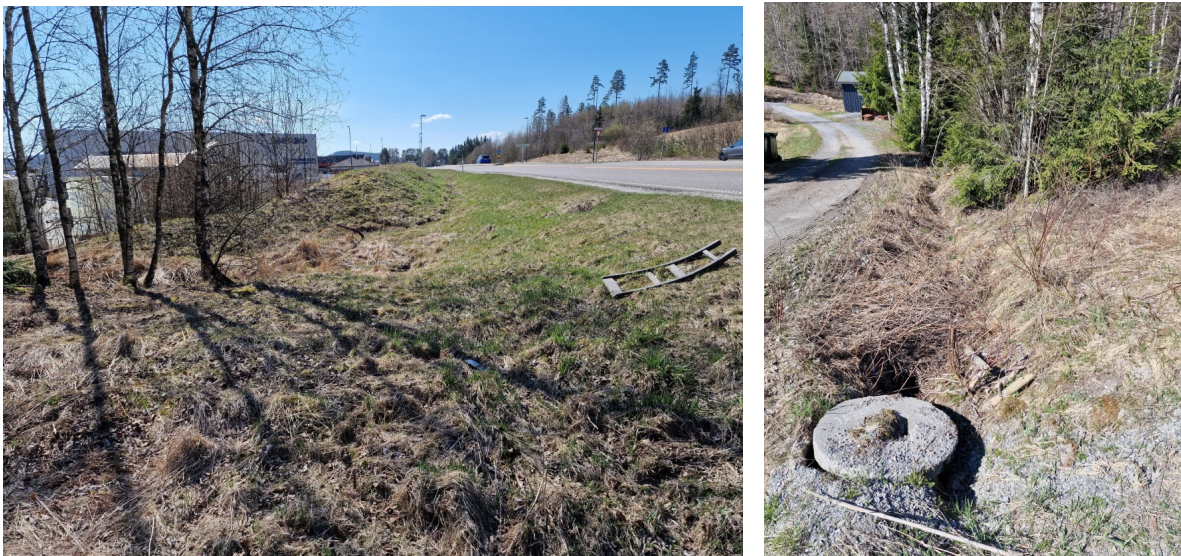
Figur 23: Bilder tatt på befarings 8.mai 2023. Bilde til venstre viser Kompveien i retning sør. Bildet til høyre viser eksisterende drenggrøft og kum langs veien opp mot Blikrudåsen.
