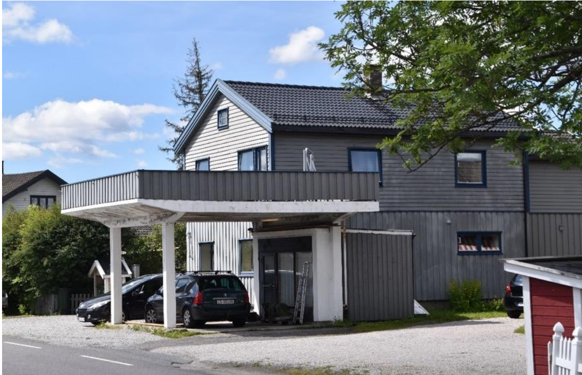
Reg.nr. 27.20: Kombinert villa og forhenværende bensinstasjon i Stasjonsveien
