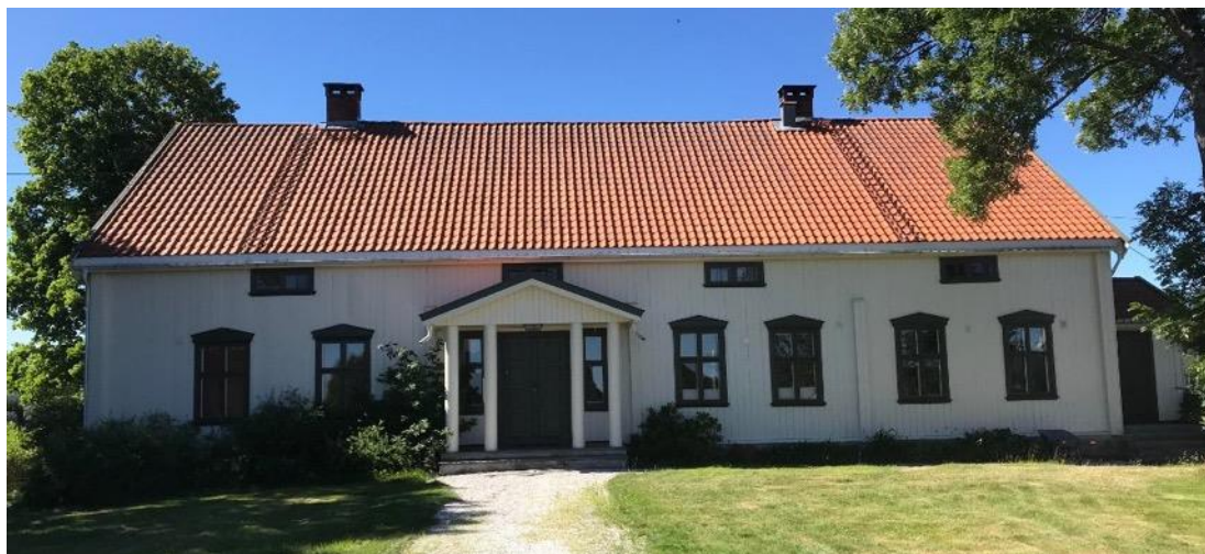
Reg.nr. 37.7: Hovedbygningen på Høland prestegård.
