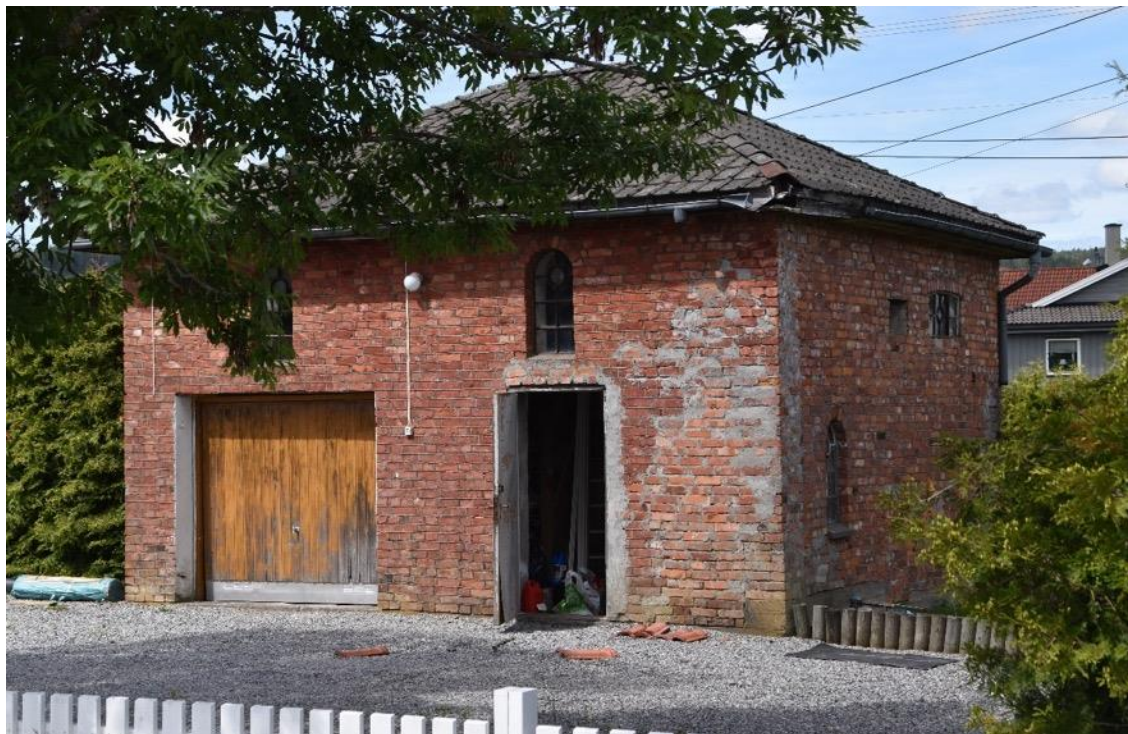
Reg.nr. 27.17: Angivelig forhenværende transformator i Stasjonsveien.
