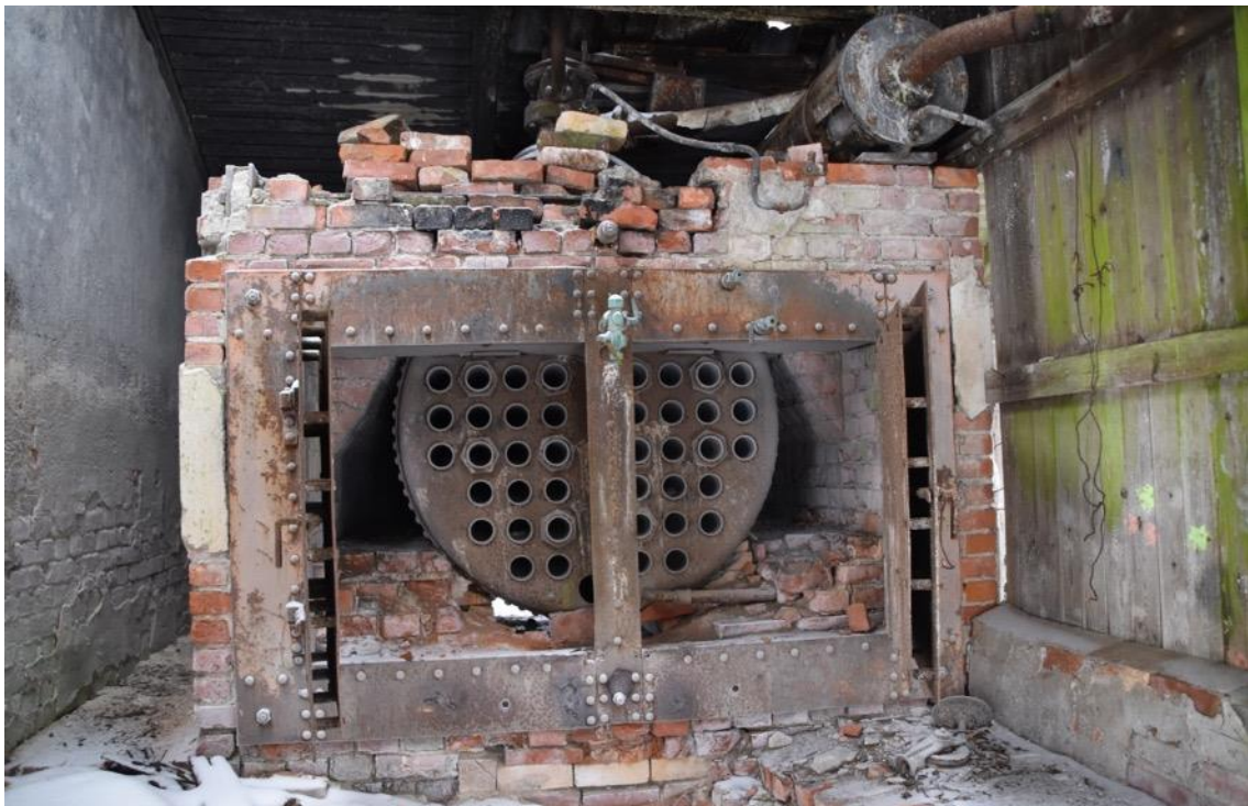
Rester av ovnen i dampsaga på Nordby.
