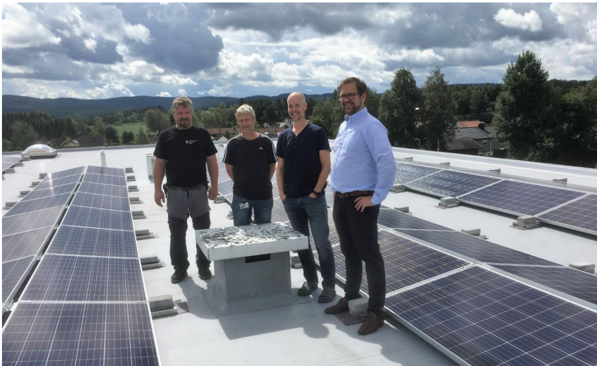
Solcelleanlegget på taket av Aurskog sykehjem. Foto: Stian Sandbekkbråten
