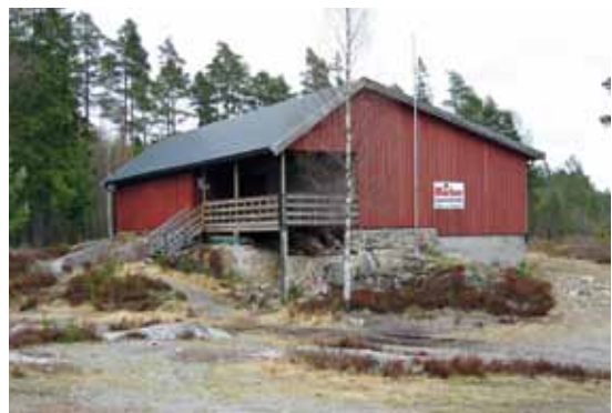
Standplasshuset ved skytterbanen etter nybyggingen i 1999. Foto: Per Haugen.
